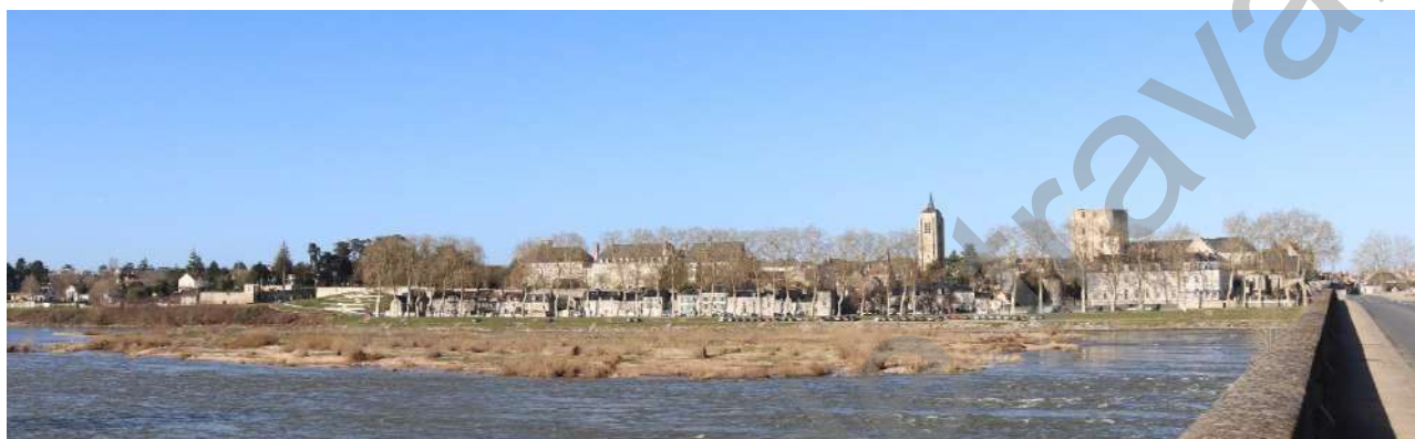
Figure 24. Front bâti de Beaugency dominé par le donjon et l'église Notre-Dame
