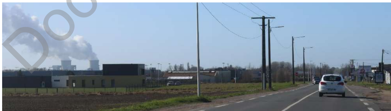
Photo 25. Paysage d'une zone d'activité le long de la D2152
