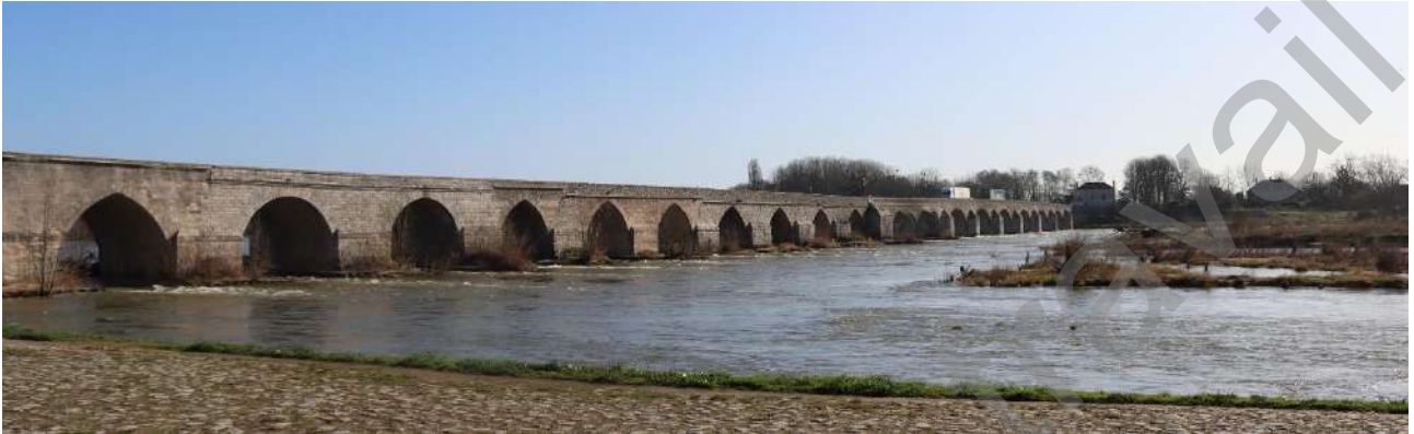
Photo 35. Pont de Beaugency et ses deux typologies d'arcs : ogival (premier à gauche) et plein cintre (deuxième à gauche)
