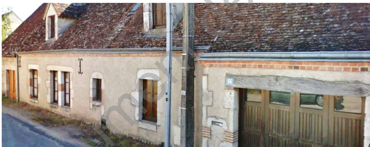
Photo 30. Exemple d'architecture avec un appareillage de briques (Google Street View)
