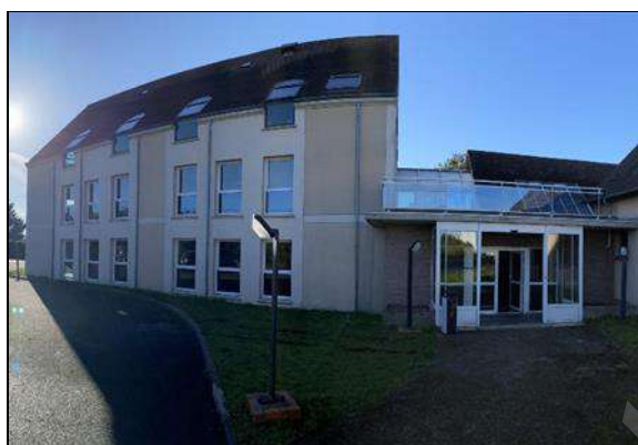
Photo 4. Vue extérieure de l'espace de coworking à Baule
